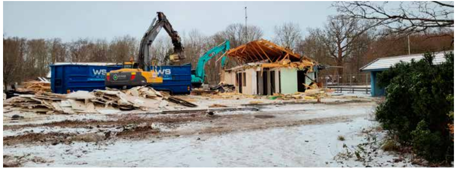
Rivning av Snickerns förskola
